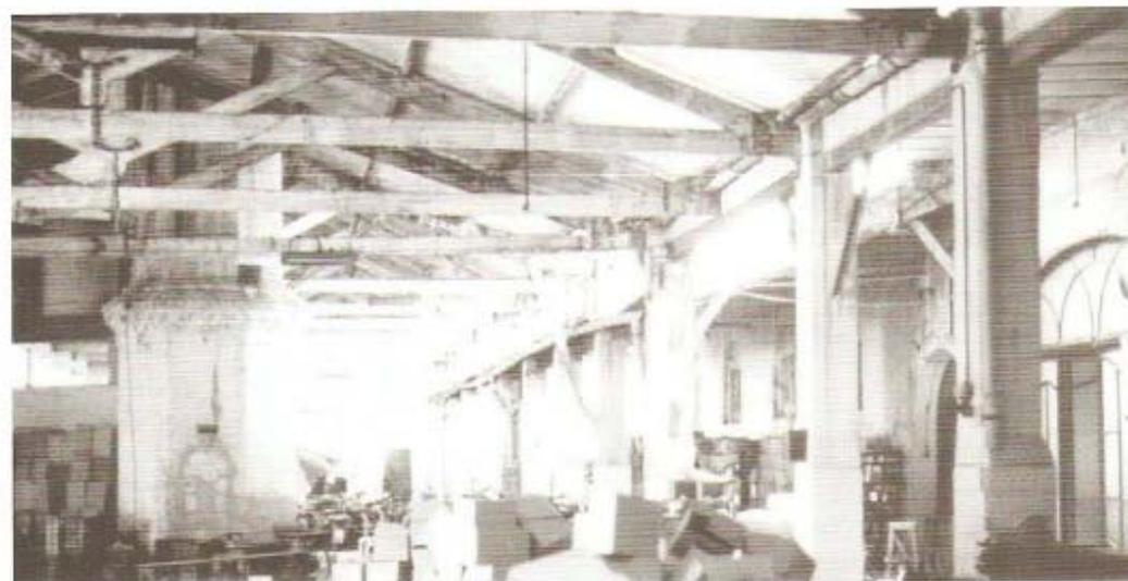
*Base o pedestal de la chimenea en el interior de la fábrica. Se distingue la puerta tabicada de acceso al aposador de humos. Año 1978. Obsérvese la construcción gemela con la chimenea de la Esencia*
