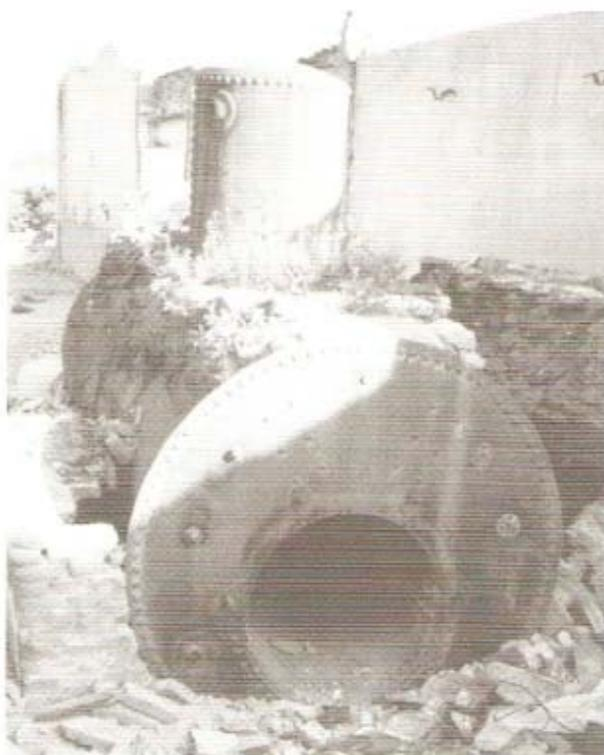
*Caldera de la fábrica extraída de su emplazamiento por el derribo de la fábrica*
